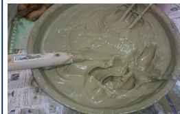
セメントを混ぜるところ
