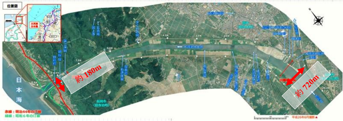
図-2 大河津分水路の全体像 1)
