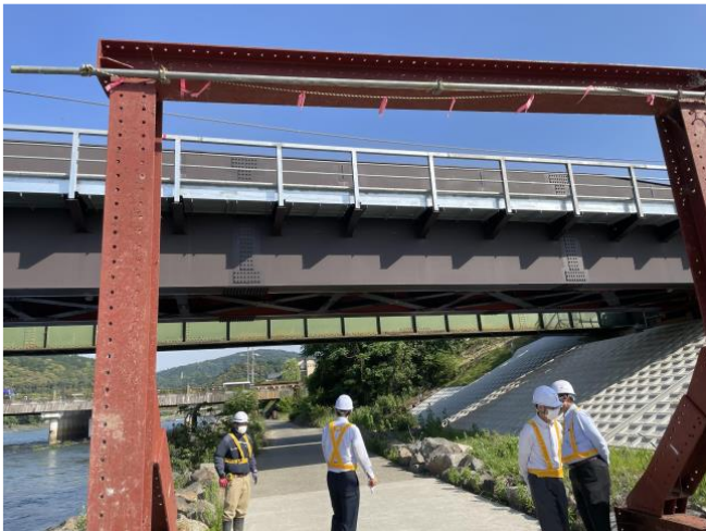
橋梁前の空頭防護にて
