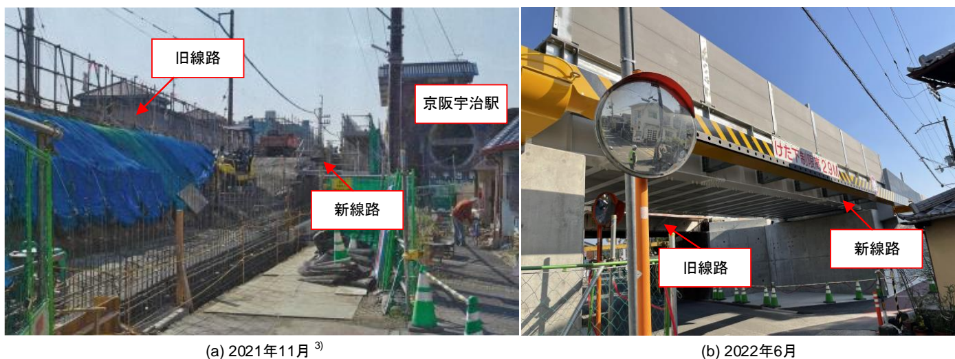
写真-1 菟道架道橋付近の複線化工事 3)
