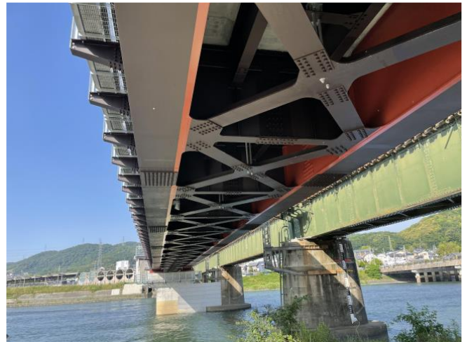
新橋梁（左）と旧橋梁（右）
