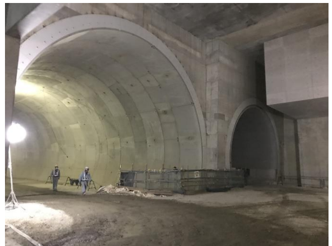
立坑最下部のシールドトンネル
