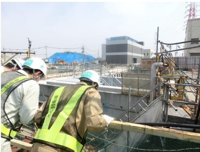
地上から立坑内部を覗く様子
