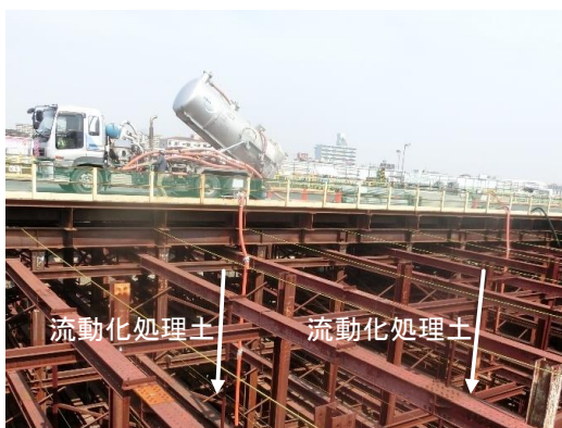
写真1 開削部埋め戻し現場
