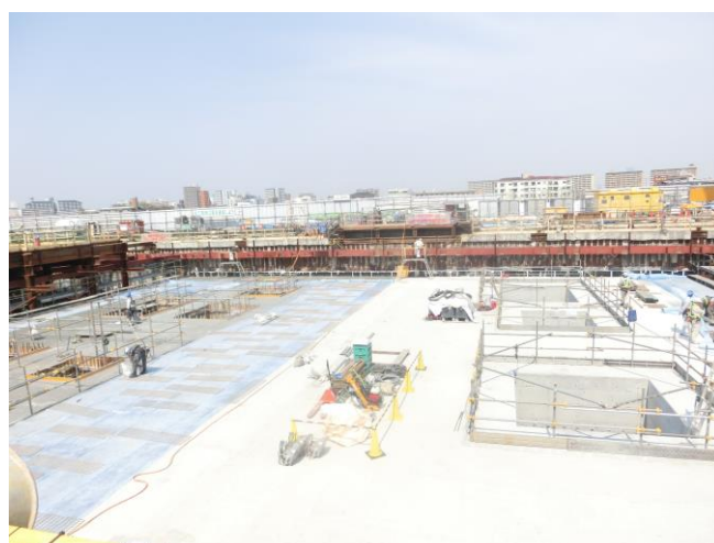
写真 5 換気所設置場所の上端面
