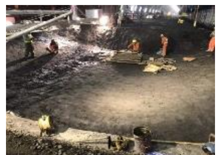
写真6 インバート施工の様子
