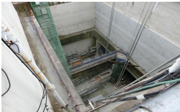
地上から見た立坑内部
