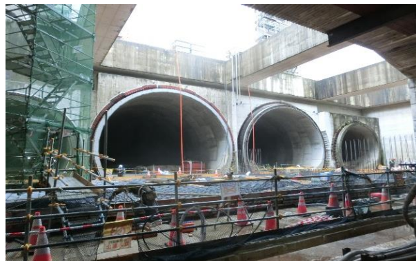
立坑最下部のシールドトンネル
