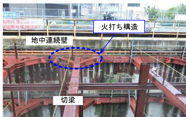
写真-2 地中連続壁を支える切梁
