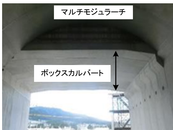
写真3 ボックスカルバートと マルチモジュラーチの接続部
