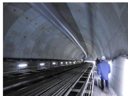
写真1 シールドトンネル
