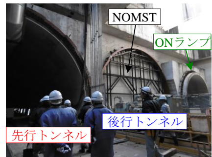
写真6 No.4立坑（先行トンネルの左側にOFFランプ）
