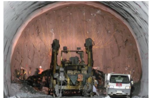
写真 1 発破に向けた装薬作業
