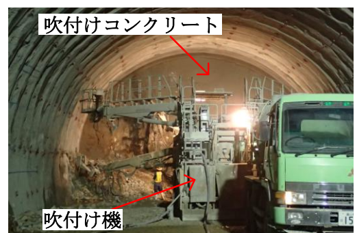
写真 2 吹付け作業
