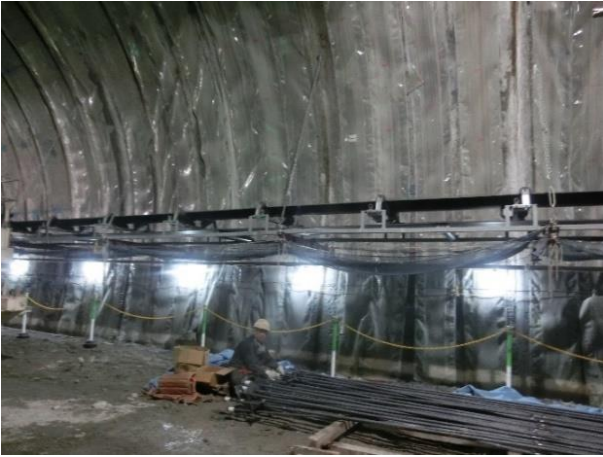
ボルト打ち込み作業
