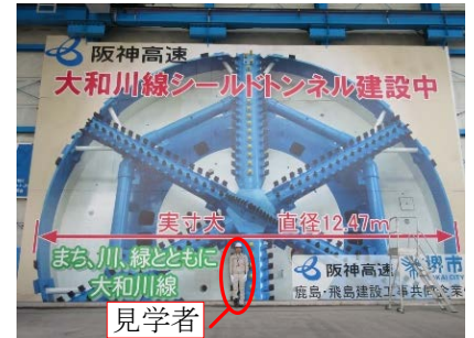
写真2 シールドマシン
