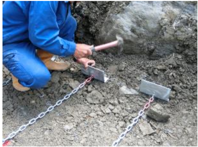
写真2 支圧板の固定
