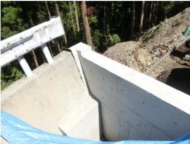
写真3 隔壁工
