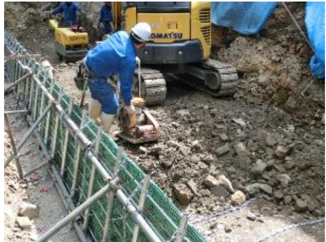
写真4 盛土材巻出しと転圧
