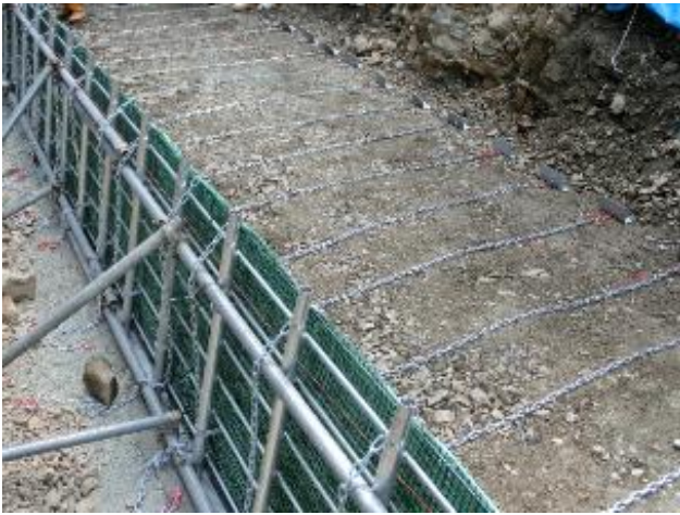
写真1 壁面工の設置
