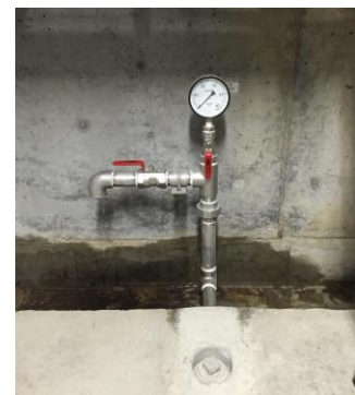
写真 4 漏水量の観測
