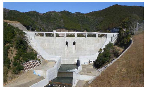
写真1 切目川ダムの概観
