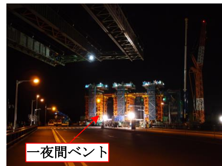
写真 6 手延べ機と一夜間ベント
