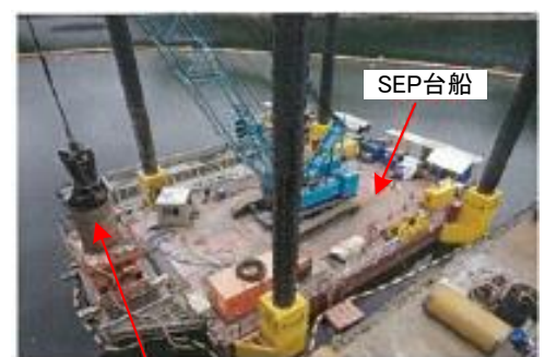
全周回転掘削機 図3 SEP台船・全周回転掘削機
