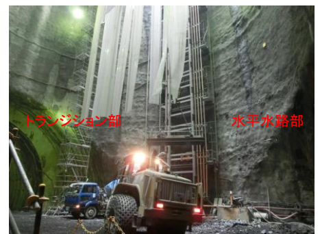
写真3 立杭部の様子
