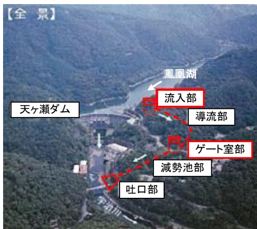
図1 天ヶ瀬ダム トンネル式放流設備
