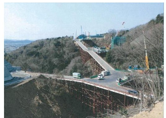
写真1 工事用仮栈橋
