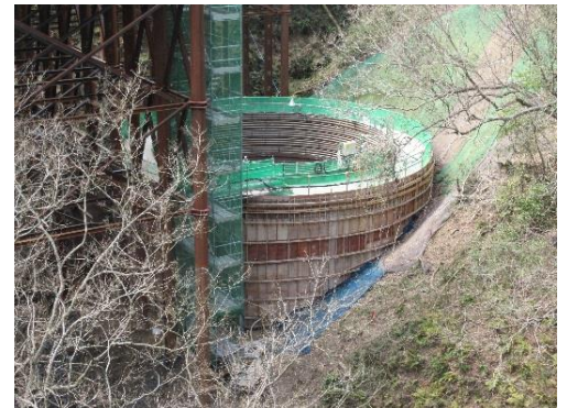
写真 2 DP2(深礎躯体)
