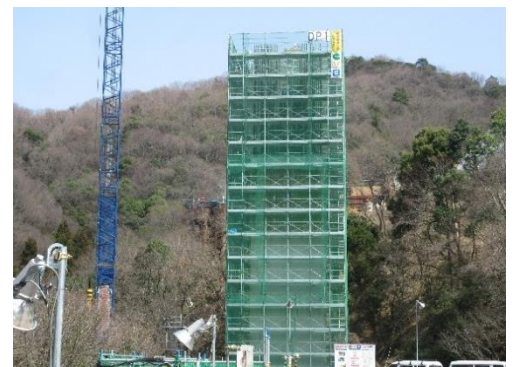
写真 3 DP1(橋脚躯体)
